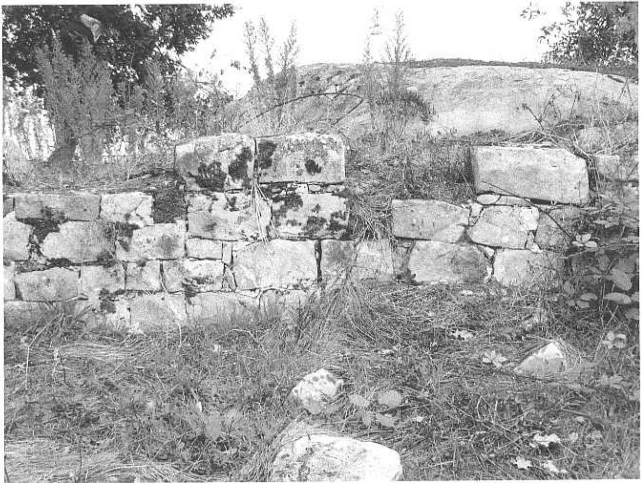
Partie de mur située sur le côté droit - photo n° 6
