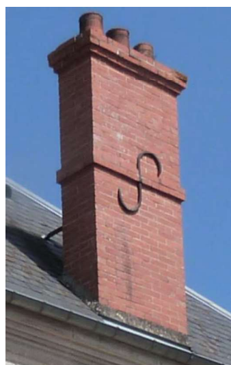
Figure 95 : Exemple d'une souche de cheminée en brique
