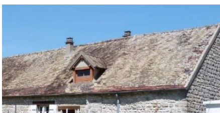
Figure 92 : Exemple d'une toiture en tuiles plates
