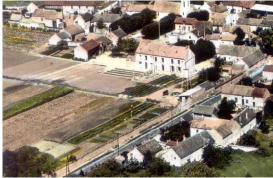
Figure 27 : Vue aérienne du prieuré dans les années 1970. Source : Oncy, parcours à travers le temps
