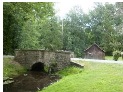
Figure 44 : Vue actuelle du pont du Closeau
