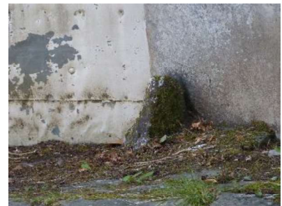
Figure 84 : exemple d'un chasse-roue, rue du général Leclerc
