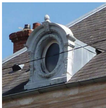
Figure 98 : Exemple d'une lucarne œil de bœuf
