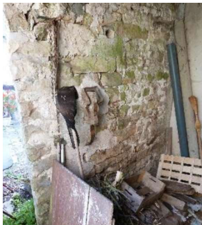
Figure 49 : Puits bouché chez un particulier, rue Lantara
