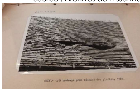
Figure 60 : Carte postale ancienne de 1969 montrant un toit aménagé pour le séchage des plantes. Source : Archives de l'Essonne
