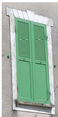
Figure 89 : Exemple d'un encadrement d'une baie travaillé
