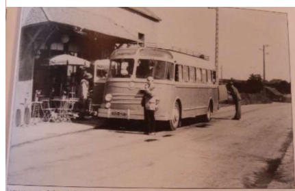
Figure 69 : Carte postale ancienne de 1949 de l'Arrêt de Routiers. Source : Archives de l'Essonne
