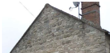
Figure 94 : Exemple d'une maison ancienne avec une rive en ruellée
