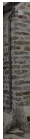
Figure 86 : Exemple de chaînage d'angle
