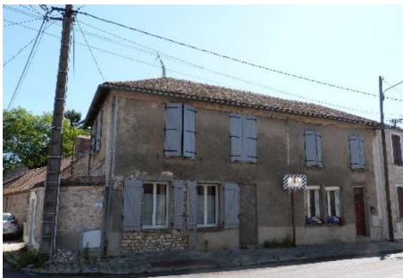
Figure 65 : Vue actuelle du 113 Grande Rue
