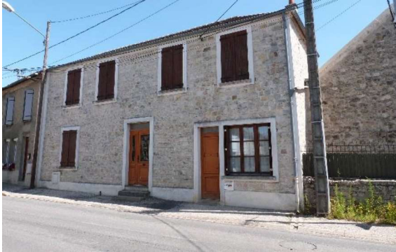
Figure 39 : Exemple d'une maison de bourg sur la Grande Rue
