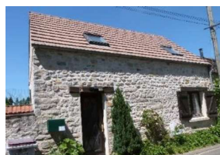
Figure 93 : Exemple d'une toiture en tuiles mécaniques
