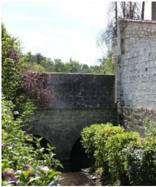
Figure 45 : Vue actuelle du pont de la Grande Rue
