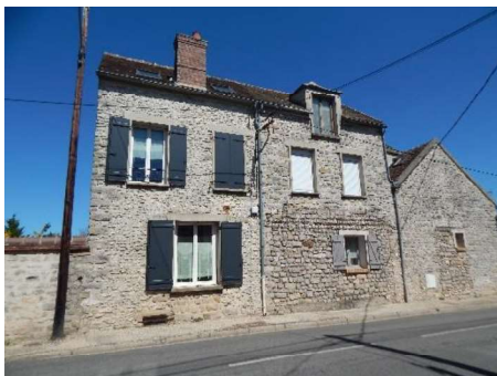
Figure 63 : Vue actuelle du 107 Grande Rue
