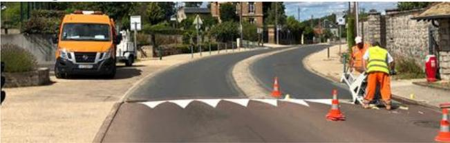
Avec l'aide du département, la Mairie a fait une campagne de mesure des vitesses pratiquées Grand Rue. Des ralentisseurs provisoires vont être mis en place début septembre à des endroits sensibles et permettront de mesurer l'impact de la mesure.
